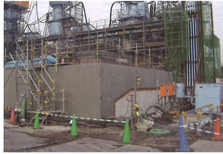
ケーソン外防水施工例
