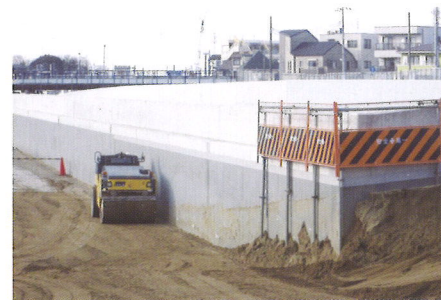
側壁部保護層無し施工例
