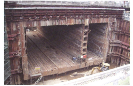
横推進工法防水施工例
