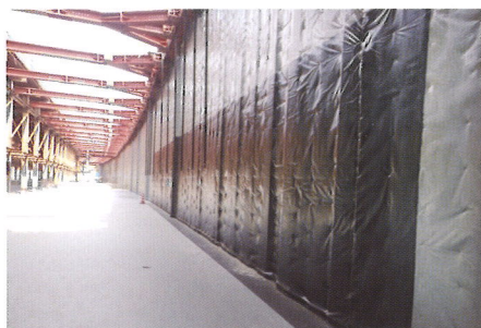
先施工防水例
