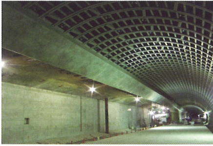
シールド鋼殻切開き部施工例
