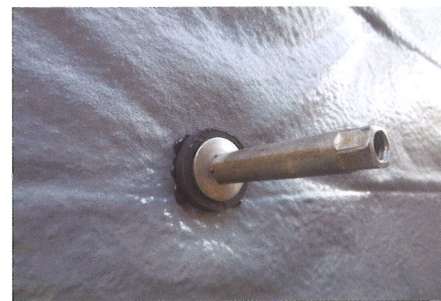
セバ部施工例
