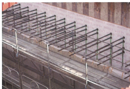
先施工ジベル筋部防水例
