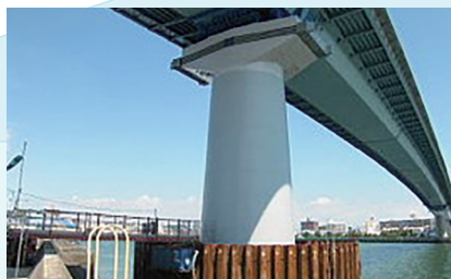
RC巻立保護塗装工
