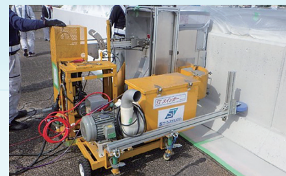
自動塗装機による壁高欄塗装工
