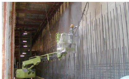
大型建築物地下防水工
