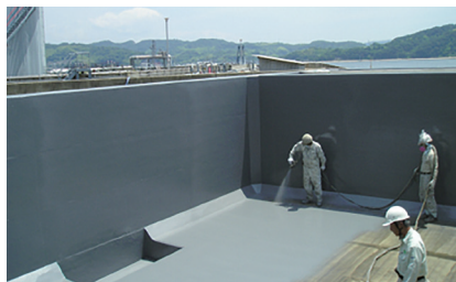
沿岸構造物表面被覆工
