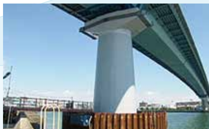
RC巻立保護塗装工
