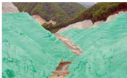
廃棄物処分場吹付遮水工
