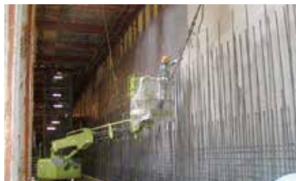
大型建築物地下防水工
