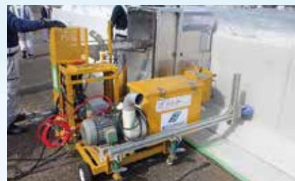
自動塗装機による壁高欄塗装工
