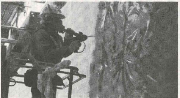
S-QS工法は超速硬化ポリウレタンポリウレタン樹脂吹付塗膜材料をコンクリート構造物の表面に塗布することにより、水分、塩分、炭酸ガス等のコンクリート劣化因子を遮断する表面被覆材。優れた伸び率と強度により下地の亀裂に対して追随性の高い材料なので、現在までに道路・鉄道その他重要構造物の地上、地下における表面被覆工法として幅広く認知され、国内外で普及している。
