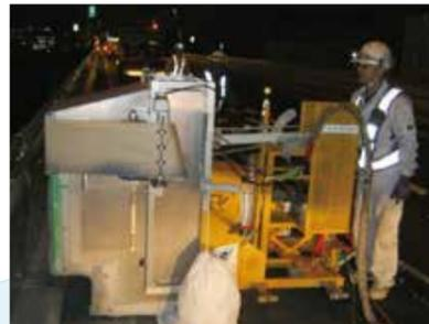
自動塗装機による壁高欄塗装工事
