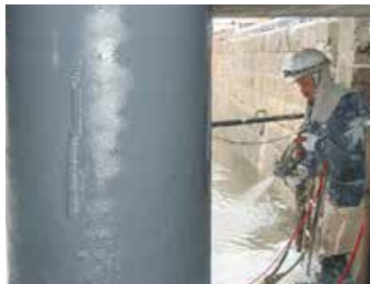
鋼管杭防食工事
